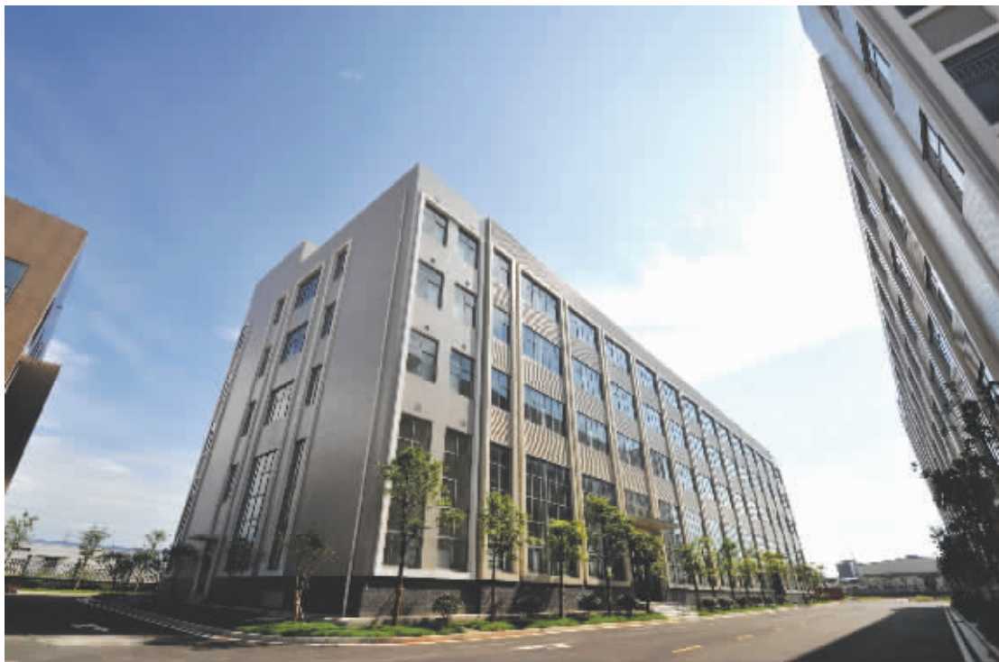
目前,金海钢构承建的省内首栋盒式钢结构标准厂房在九华创新创业中心已经落成。
