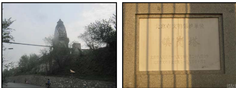
图 3-1 镇岗塔现状照片
