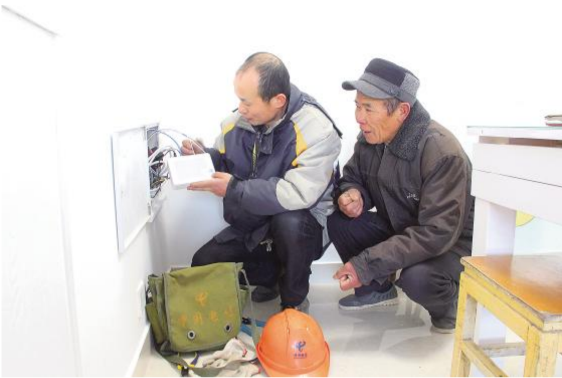
近日,射阳电信分公司加紧为搬安置区的灾民提供装、移机“一站式”服务,受到群众的好评。图为1月14日,电信员工为陈洋居委会灾民陈国雅家安装宽带。 陈允标 摄
