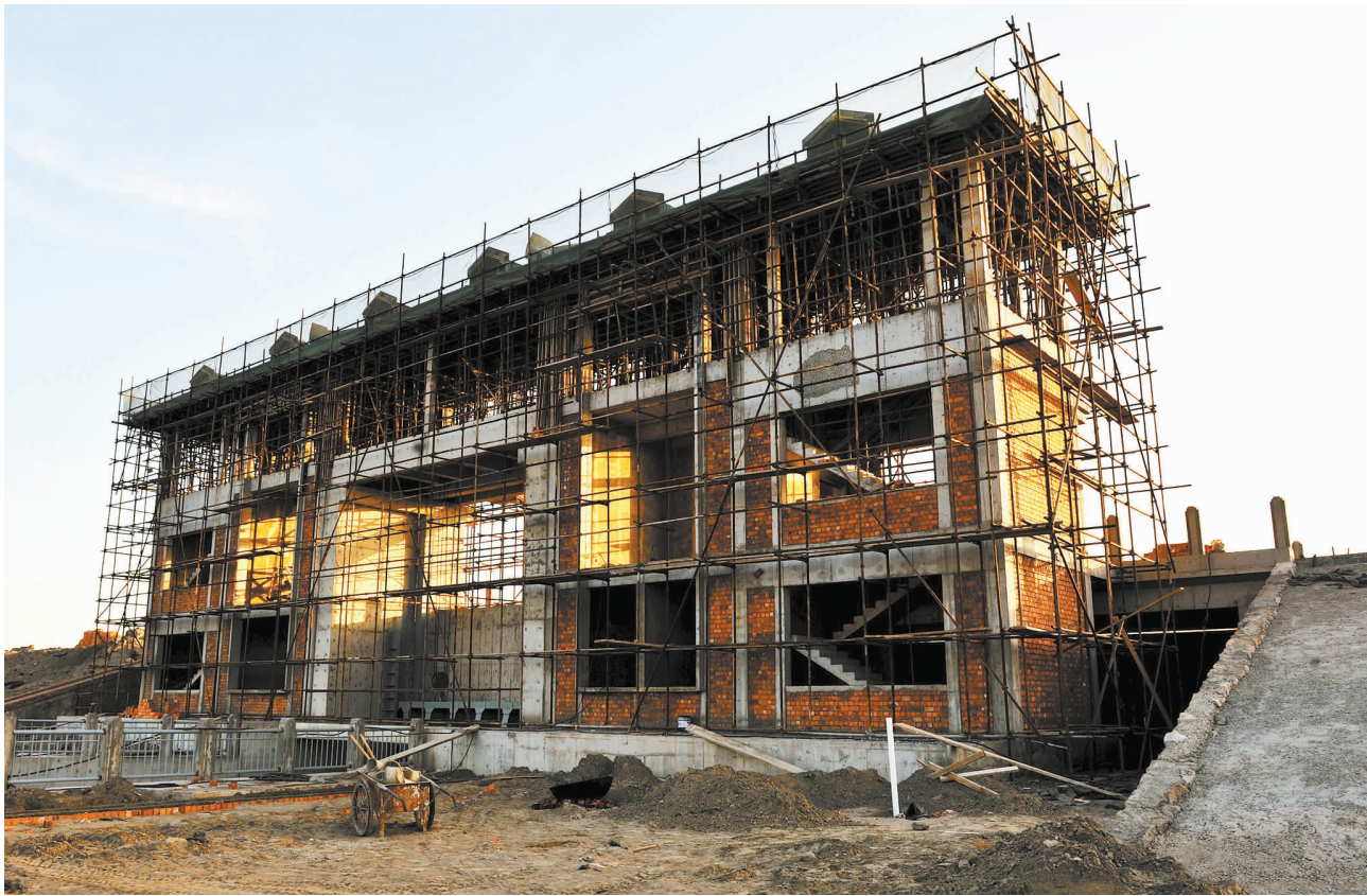
吕四新港位于大唐吕四港电厂东侧,由水务局组织实施。工程于2012年初开工,总投资1600余万元。新闻排涝能力将比老闸提高30%。图为即将竣工验收的新港闸。
