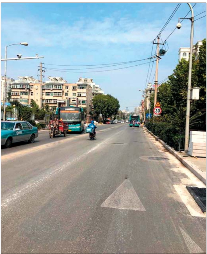
建设路供热主管网改造24日完工恢复通车。
