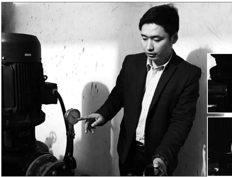
短短30分钟,二次供水管网的水压下降十分明显。本报记者 康宇 摄
