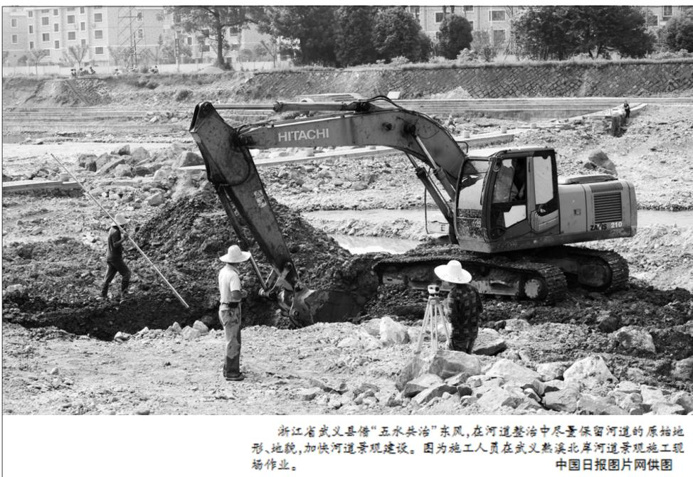
浙江省武义县借“五水共治”东风,在河道整治中尽量保留河道的原始地形、地貌,加快河道景观建设。图为施工人员在武义县熟溪北岸河道景观施工现场作业。 中国日报图片网供图
