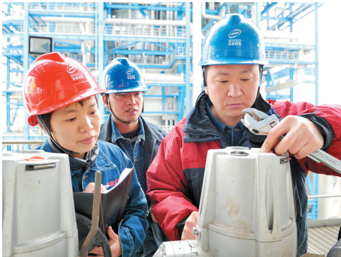
华美热电公司引领党员干部以新气象新作为争当建设新徐矿排头兵,在2#机组检修期间,公司党员干部盯现场,强管理,确保机组检修质量。 本报记者 孟婕 摄
