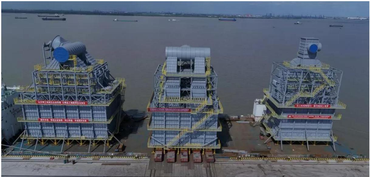
天图物流旗下江苏永捷工程物流有限公司（简称“江苏永捷”）运用自有设备 SPMT 自行液压式模块车承运的浙石化 4000 万吨/年炼化一体化项目 PX 装置 13 台歧化加热炉项目圆满结束。
