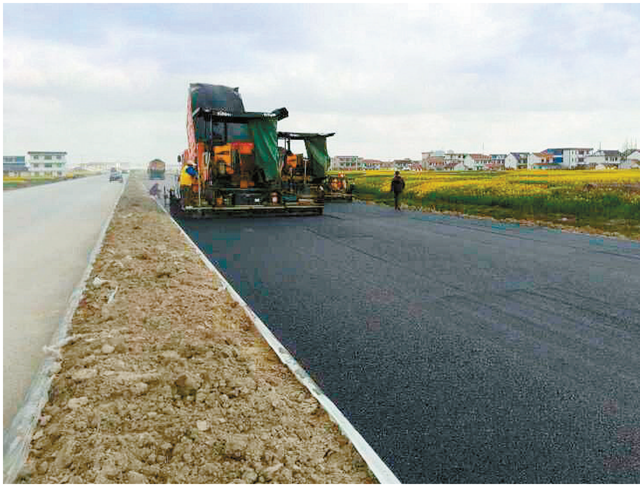
4月1日,天汾大道进行路面沥青摊铺。天汾大道是我市天汾集镇和吕四港镇之间一条南北向的快速通道,按照一级公路标准建设,预计5月份竣工通车。 柏国栋 姜新春摄
