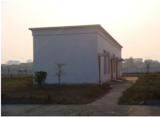
中燃公司变配电房
