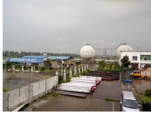
已建加气母站与储气罐
