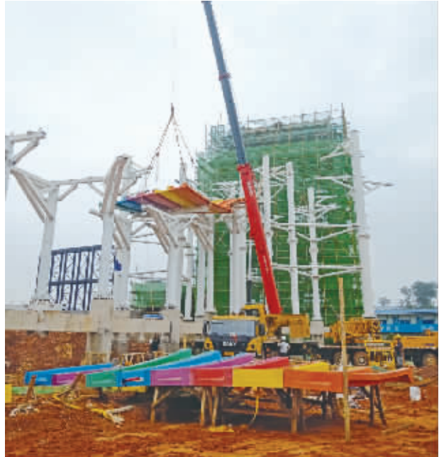
5月14日，在湖南湘江新区大王山片区的湘江欢乐城欢乐水寨项目施工现场，一块块玻璃钢滑道被吊起。 记者 陈月红 摄
