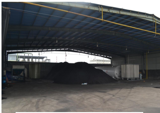
煤场防尘整改前
