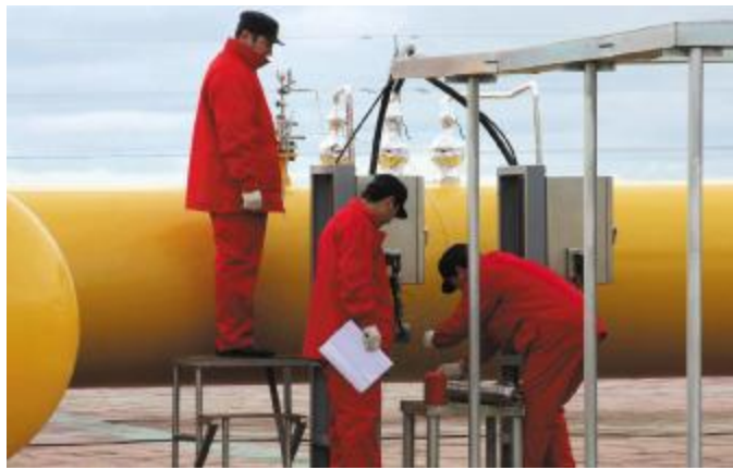
西气东输二线向广东供气在即，价格矛盾再次凸显。 图片来源：bqec.org.cn
