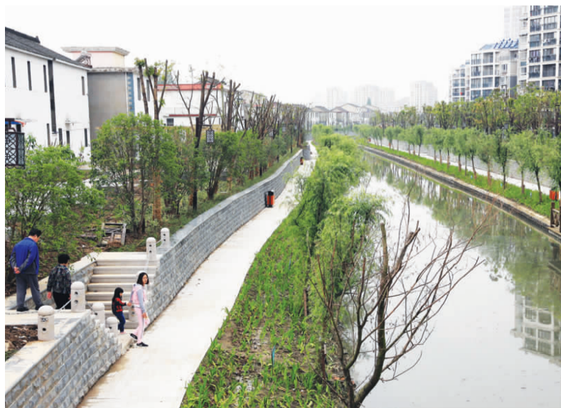
去年“双十”重点工程南澄子河综合整治工程，经市水利部门一年多的施工建设，目前主体工程已竣工，正在进行扫尾完善工作。 图为南澄子河珠光路路段新景观。 王林山 摄
