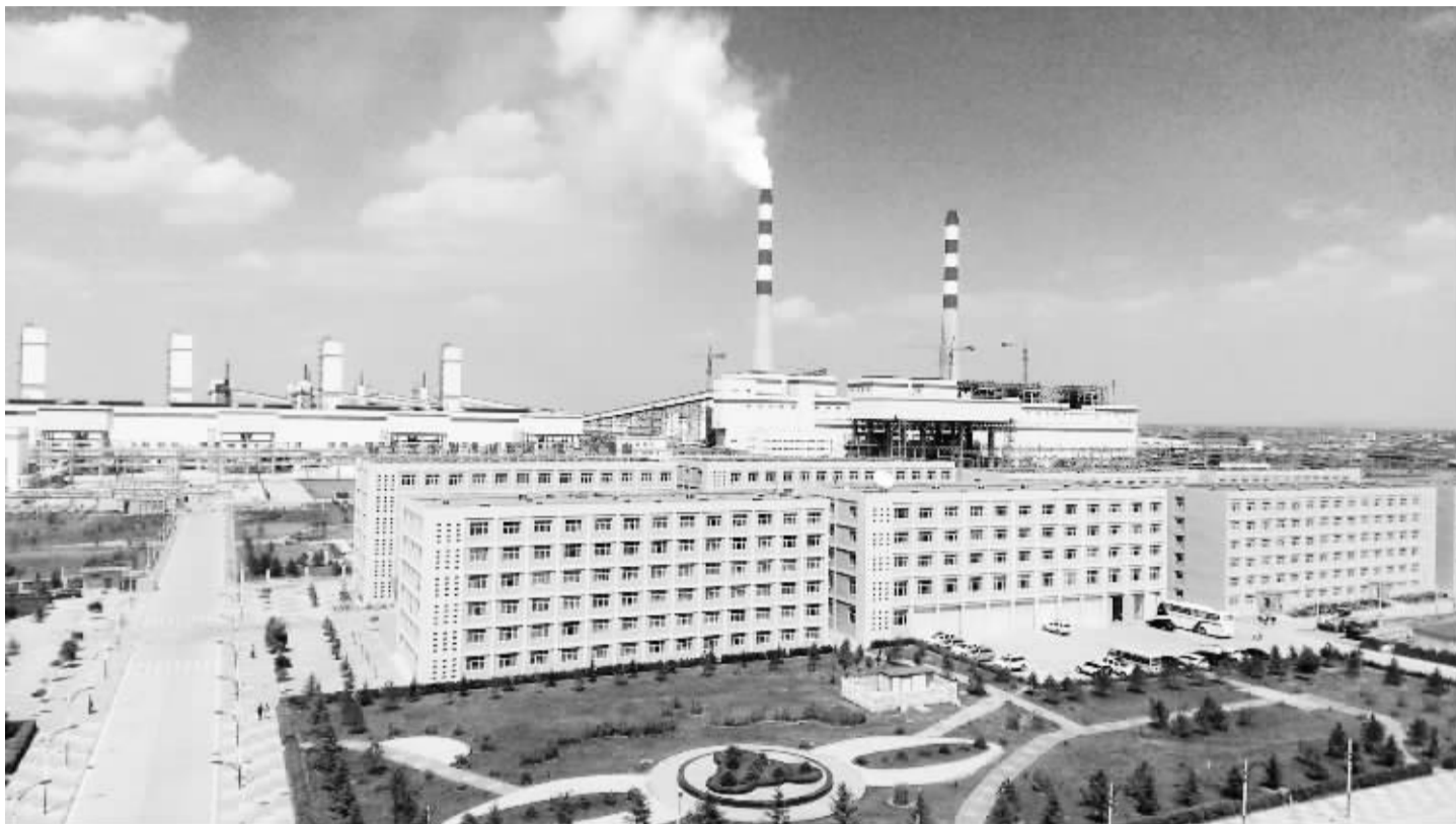
大唐国际内蒙古克什克腾旗40亿立方米煤制天然气示范项目园区概貌。
