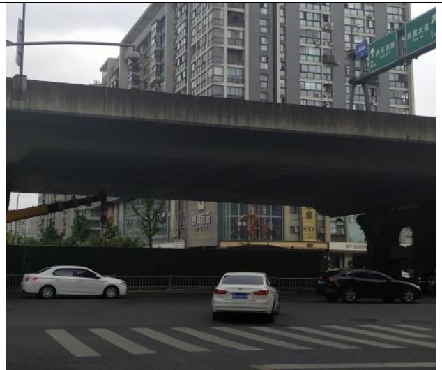
现状图 10——二环路南四段高架桥
