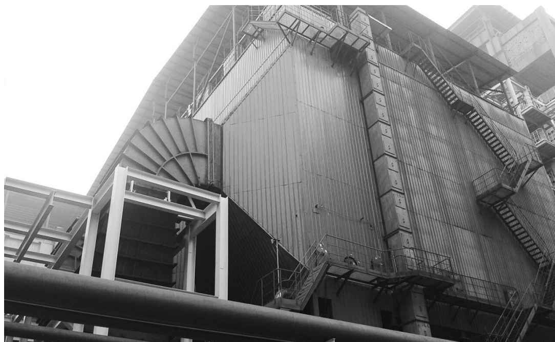
图为在四级静电除尘器的基础上,加设的第五级径流式电除尘器外观。 本报见习记者李贤义摄
