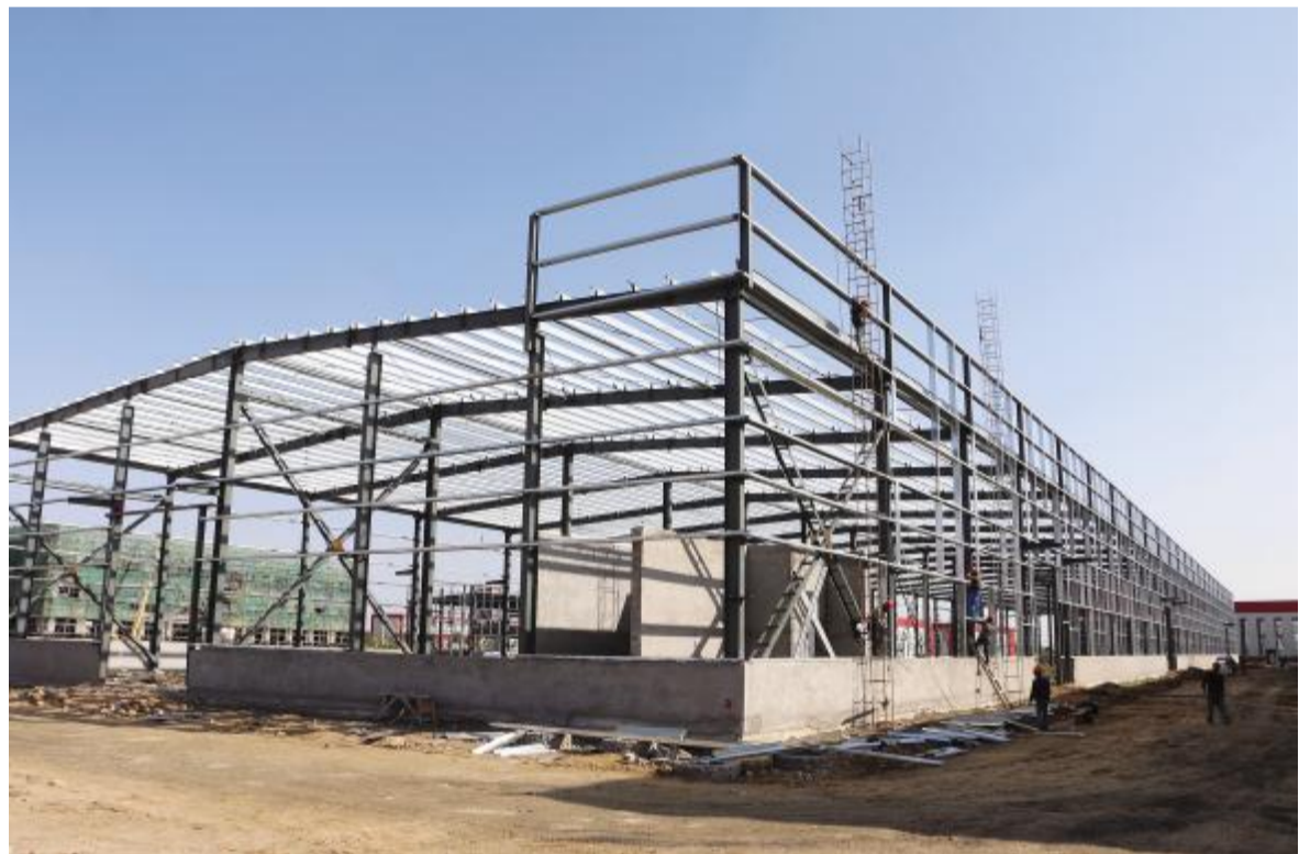
位于射阳经济开发区的智能制造业产业园,规划面积1000亩,建筑面积60万平方米,以南京大学射阳高新研究院为主要技术依托,园区入驻捷特、赛耐、利尔、鸿利等十余家汽配制造企业。目前,园区正上足马力,加大基础设施建设进度,完善园区综合服务功能。图为工人加紧建设智能化车间厂房。
