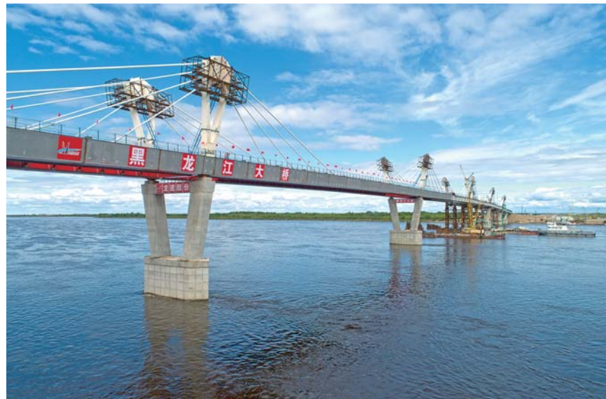
▲ 这是 5 月 31 日拍摄的中俄黑河—布拉戈维申斯克界河公路大桥。 新华社记者王建摄
