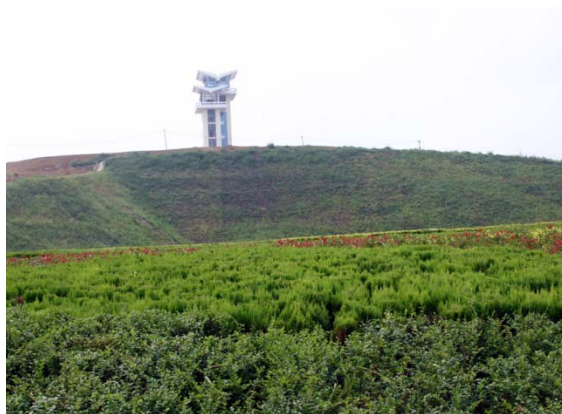
图 4.3-8 溢洪道右岸陡坡生态袋绿化。
