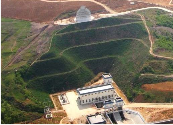
图 4.3-3 输水洞出口边坡植被砼喷护
