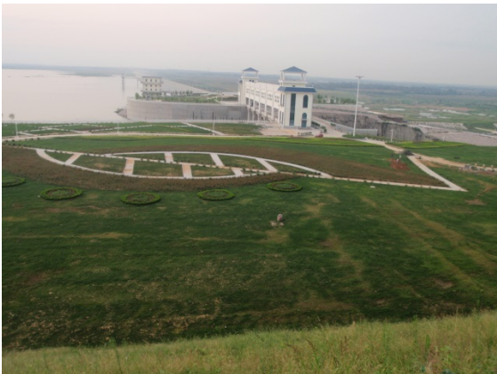
图 4.3-5 大坝右岸植被建设
