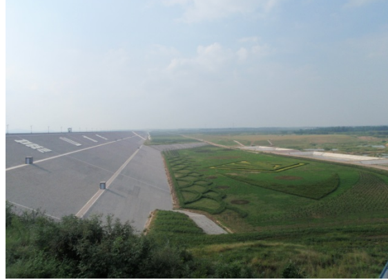
图 4.3-4 坝后区域植被建设
