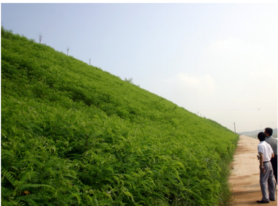
图 4.3-7 溢洪道尾水渠三维网植草护坡
