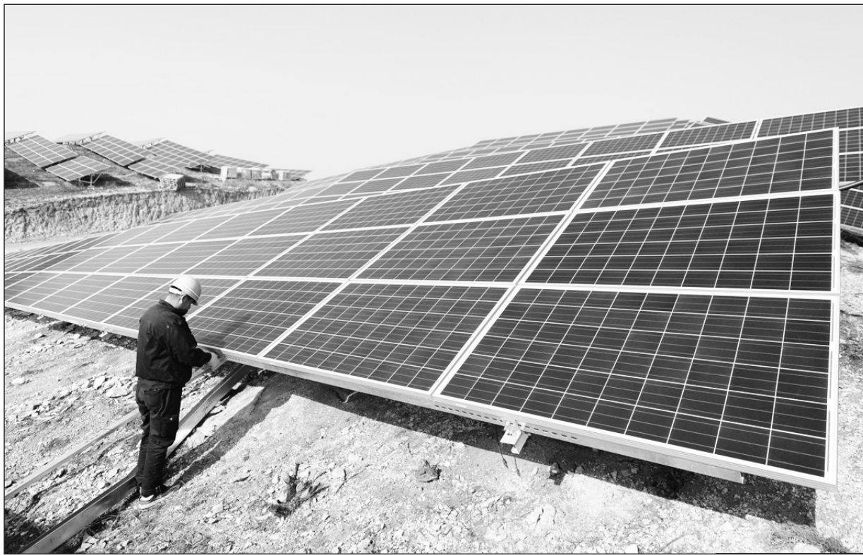
位于山东省烟台市牟平区的德联光伏项目计划总投资4亿元,占用荒山2000亩,装机总容量40兆瓦。项目一期完工后预计年发电量2400万千瓦时,年节约7700吨标准煤,年减少二氧化硫排放600吨。图为11月17日,在项目建设现场,工程人员正在安装多晶硅光伏组件。
