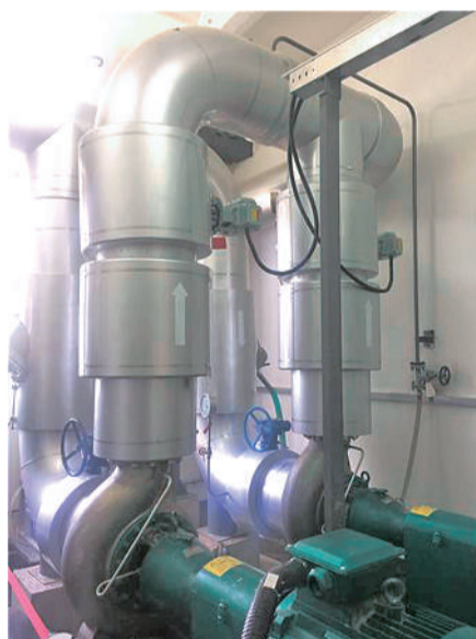
泳池式低温供热堆内部管道。 本报记者 齐 慧摄
