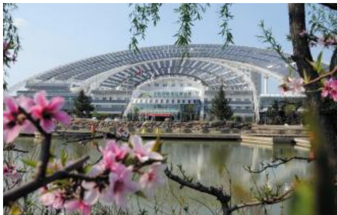
位于德州的日月坛·微排大厦是目前世界上最大的太阳能建筑,实现了太阳能热水、采暖、制冷三联供,并采用光伏并网发电、光电遮阳、北晒格栅遮阳等30多项国际国内先进技术与建筑完美的结合。该大厦建筑节能70%以上,总体节能效率达到88%。
