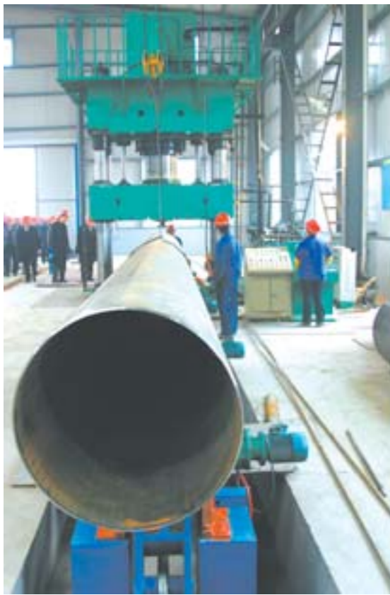
▲山东能源机械集团新驰公司的钢管生产线。
