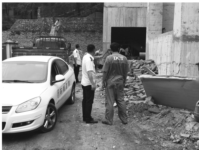
图为大连市西岗区网格员处理锅炉房扩建信访案件现场。
