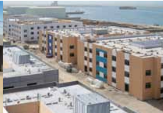
带有外挂墙板的住宅 迪拜
