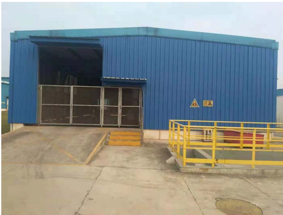
图 3.4.2-3 现有危废暂存间照片
