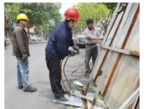
新一轮的创卫工作掀起高潮,为了美化环境,消除隐患,在县城管局的统一指挥下,各单位对辖区内的违规老旧广告牌进行清理整顿。图为广告牌拆除现场。 见习记者 盛诚 郭晴 摄
