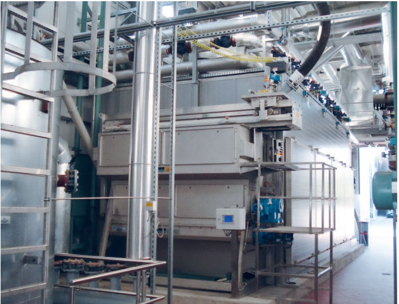
HUBER 带式干化装置 BT 通过面条机进行湿泥布料和通过横向螺杆进行干泥出料
