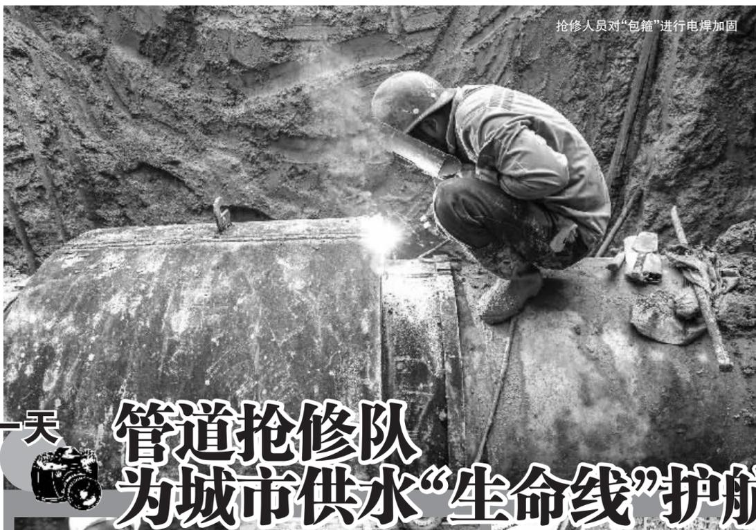
抢修人员对“包箍”进行电焊加固
