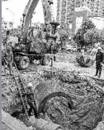
将制作好的“包箍”吊装到主管道上
