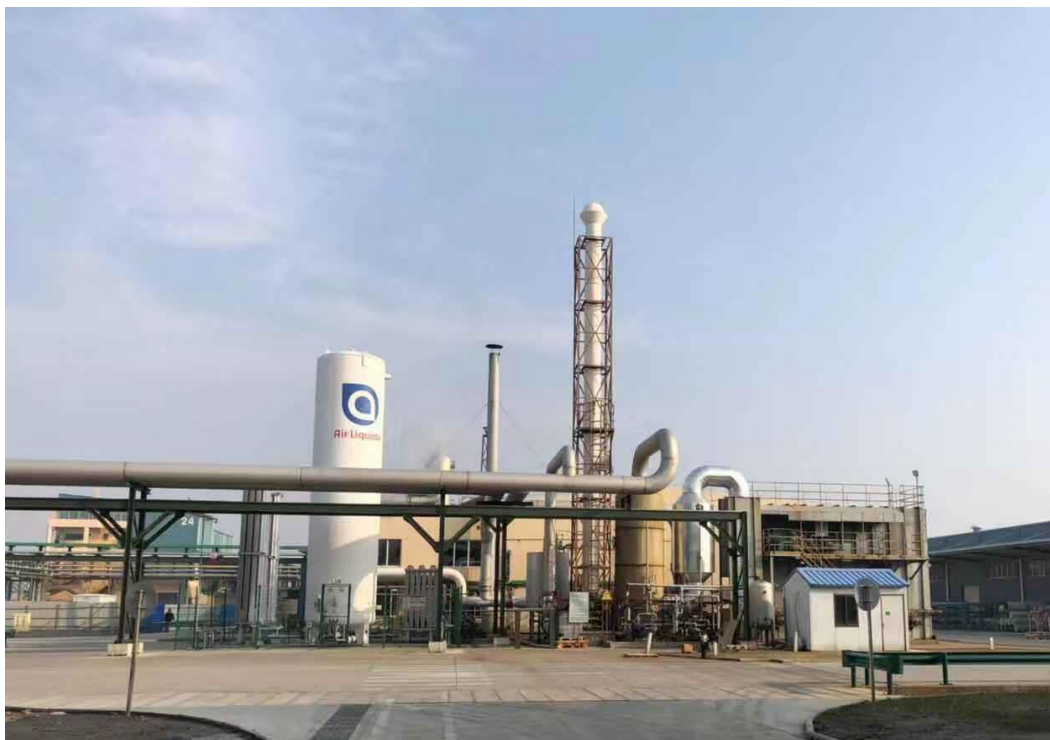
图 4.1-5 RTO 焚烧炉废气处理设施图
