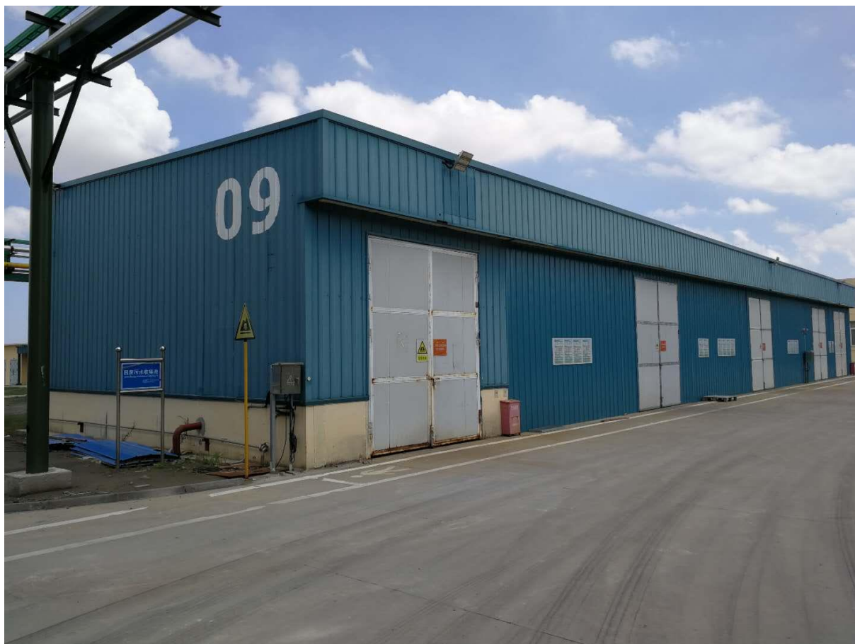
图 4.1-7 本项目危废暂存仓库
