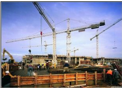
建筑施工 Construction
