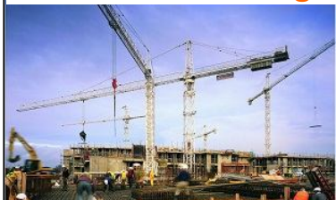
工程建设 Construction
