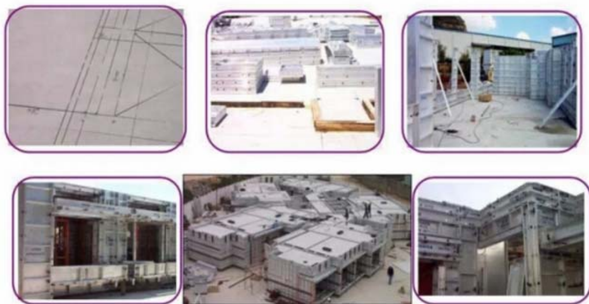
图 4-8 搭样拼装示例图
