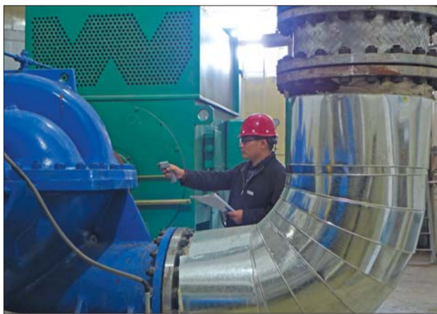
热力公司工作人员对热调试的管网温度实时监控。 本报记者 蒋龙龙 摄
