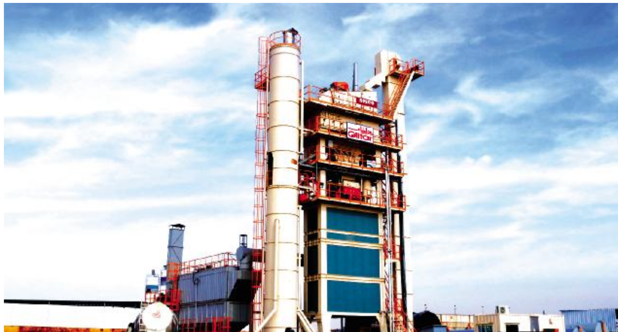
12月3日,六公司承建的科成特南穆特拉基础住房项目首座高性能沥青路面拌合系统投入使用。该系统配备全自动电脑控制室,能实现自动化作业。
