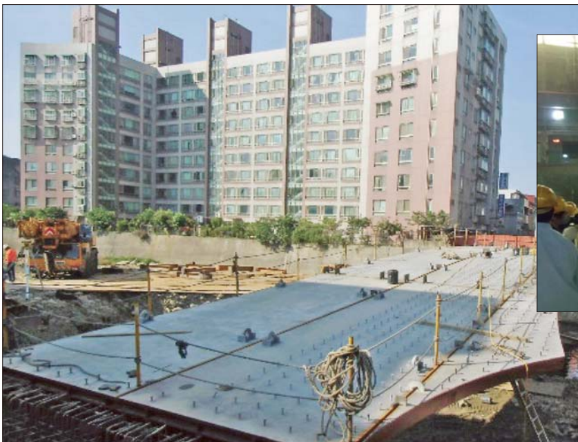
圖 18 桃園宏大橋，箱梁鍍鋅時採翻轉 90 度方向浸鍍
