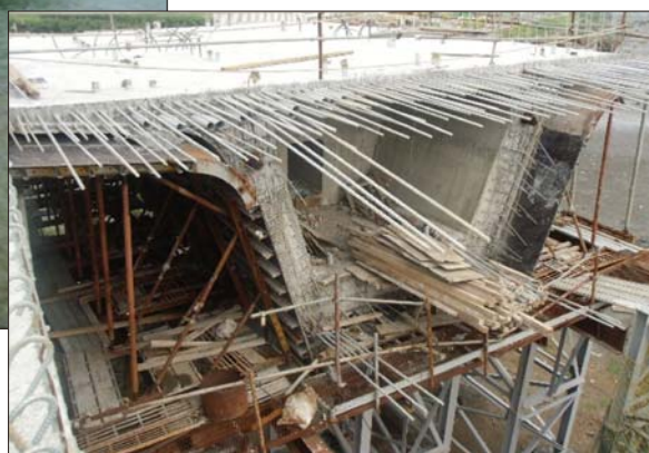
圖 19 鹿安橋，全橋鋼筋採用熱浸鍍鋅
