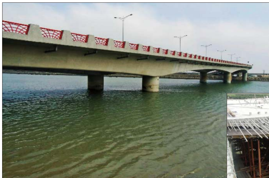
圖 19 鹿安橋，全橋鋼筋採用熱浸鍍鋅
