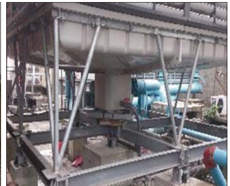
圖 8 大樓空調系統冷卻水塔一律採用熱浸鍍鋅
