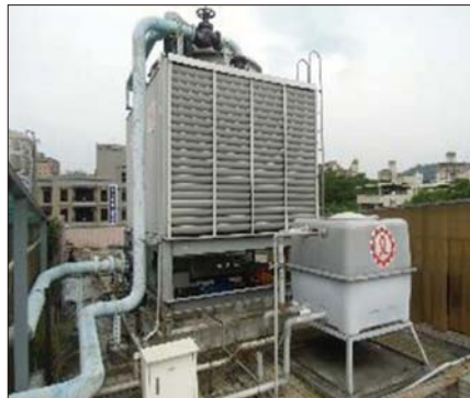
圖 8 大樓空調系統冷卻水塔一律採用熱浸鍍鋅
