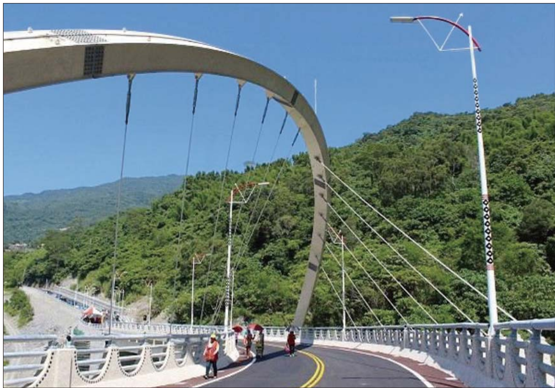
圖 15 松楓橋，採用鋼板先鍍鋅再組銲成箱梁
