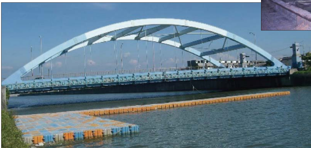
圖 14 第一座熱浸鍍鋅鋼拱橋—福興橋
