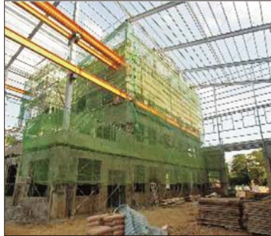
圖 4 熱浸鍍鋅廠房(2)，柱子採用箱梁 ，A325 螺栓經熱浸鍍鋅(上)，H 型鋼為主，RC 包覆 H 鋼柱(下)
