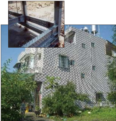
圖 7 921 地震災後重建採熱浸鍍鋅鋼構房屋
