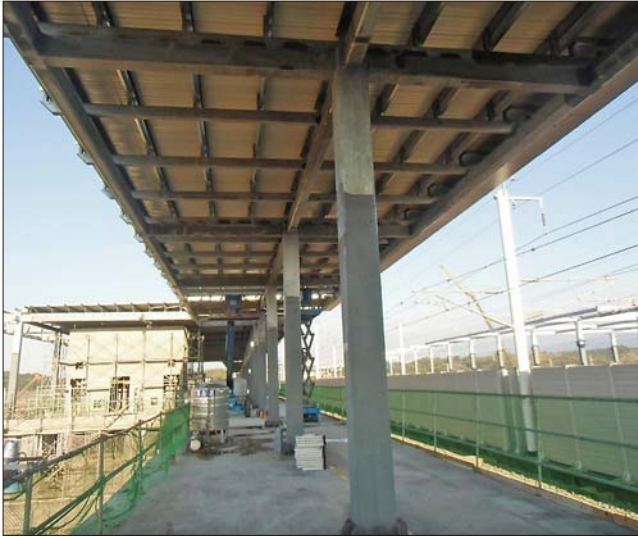
圖 11 高鐵苗栗站月台鋼架採用熱浸鍍鋅處理
