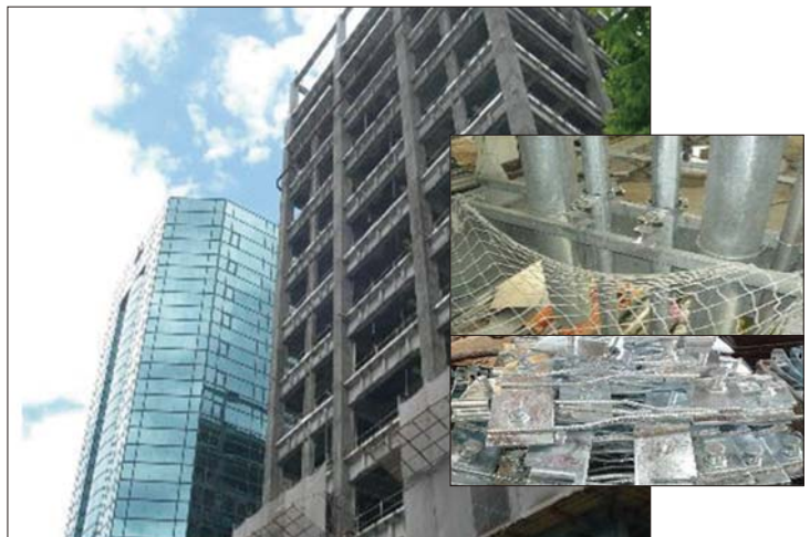
圖 10 大樓帷幕牆預埋件、消防系統、配件採用熱浸鍍鋅防蝕
