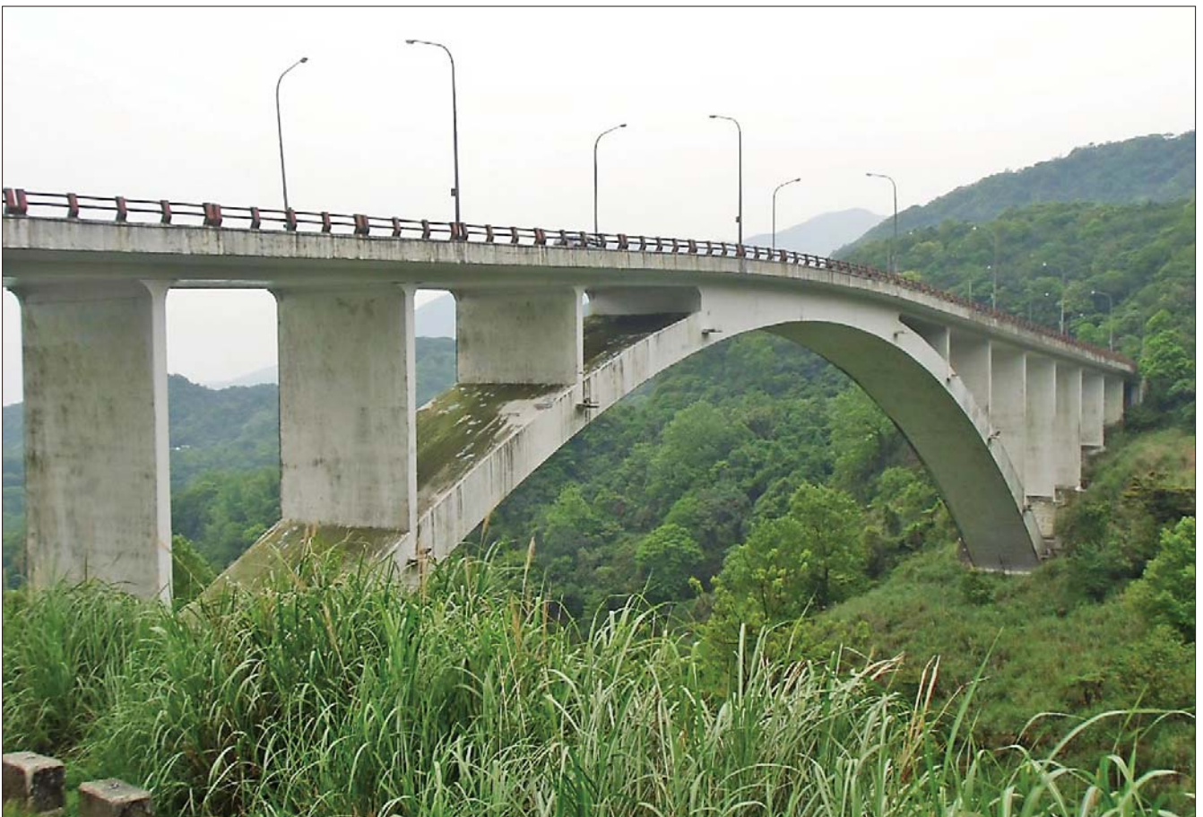
圖 12 台灣第一座熱浸鍍鋅橋梁－馬槽橋
