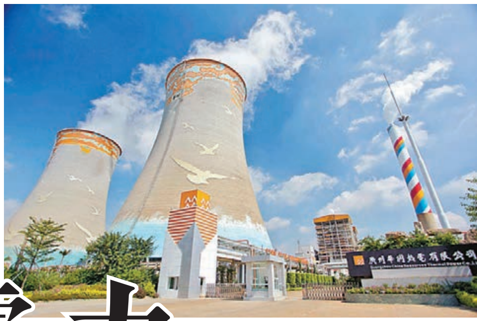
循環水冷卻塔
