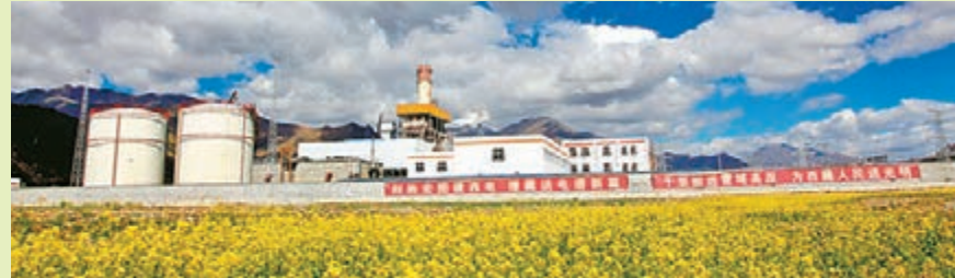
華潤電力投資8.2億元向拉薩捐建燃機電站，是世界上海拔最高、單機容量最大的9E級燃機。
