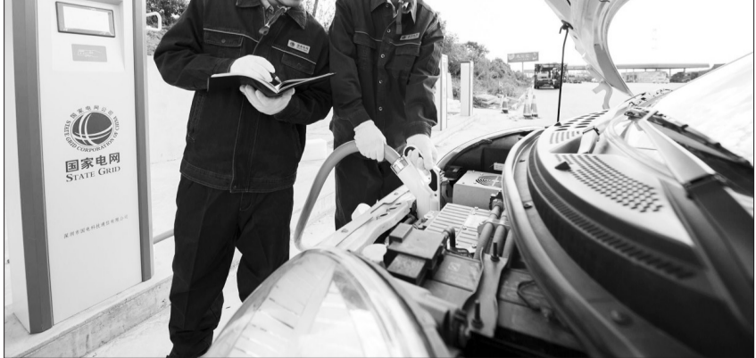
安徽省马鞍山市供电公司投资建设的当地首个高速公路电动汽车充电站于近日送电成功,计划本月将正式投入运营。据悉,这个充电站在高速公路的双行服务区各建有4个充电桩,共8个充电桩,充电电机功率120千瓦,可满足8辆电动汽车同时充电,在电动汽车电量下可在1小时内充满电量。 人民网供图
