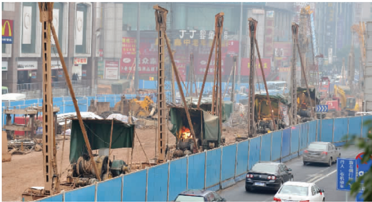
1月4日下午,长沙市地铁五一广场建设工地,工人们在紧张施工。近日长沙实施“冰点停工令”,地铁和隧道等在确保安全前提下可继续施工。 记者 田超 实习生 陈杰 摄
