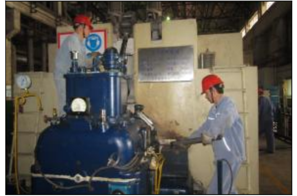
近日,随着生产生活采暖退出,根据生产运行方式的调整,晋铝冶炼公司热电项目部抓住有利时机组织对5号汽轮发电机组停机消缺。员工在积极配合电气设备进行春检的同时,组织完成了1号瓦、高加及安全门等14项缺陷的处理。图为检修员工拆卸5号机组机头螺栓。摄影报道 陈文都
