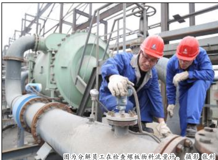
图为分解员工在检查螺板物料流量计。摄影 张利
