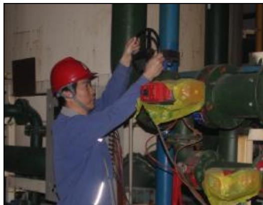
人物简介:李贤会,45岁,热电厂化学车间设备点检员。通过对单号混床入口加装手动调节阀控制冷水进水量,实现了各离子交换器温度调节可控,每天可降低成本约4900元。
