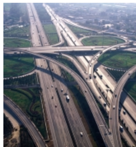
機場高速公路
