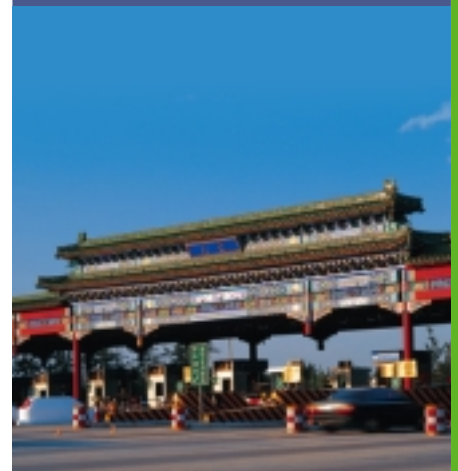
首都機場高速公路的天竺收費站
