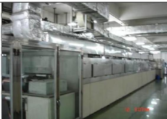
图 5-4 涂布机密闭循环烘烤系统
