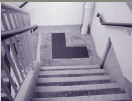
Hazard warning tiles at landings 樓梯平台上的危險警告引路磚
