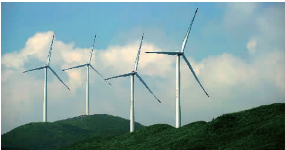
日前,桂阳县荷叶镇鲁荷金风力发电机组,该风电场二期工程正在进行并网发电测试。目前,桂阳正在打造湖南“风电之都”。 记者 郭立亮 通讯员 欧阳常海 摄
