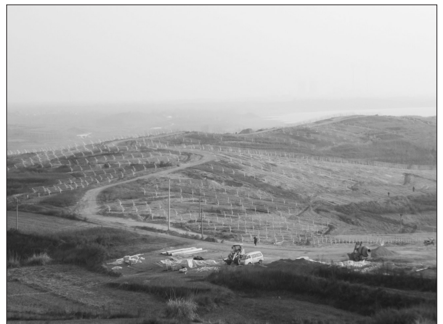
河南省南召县大山庙乡10MWp光伏电站日前动工,预计投产后平均年发电量可达1000余万千瓦时。图为正在兴建中的光伏电站。 徐培根
