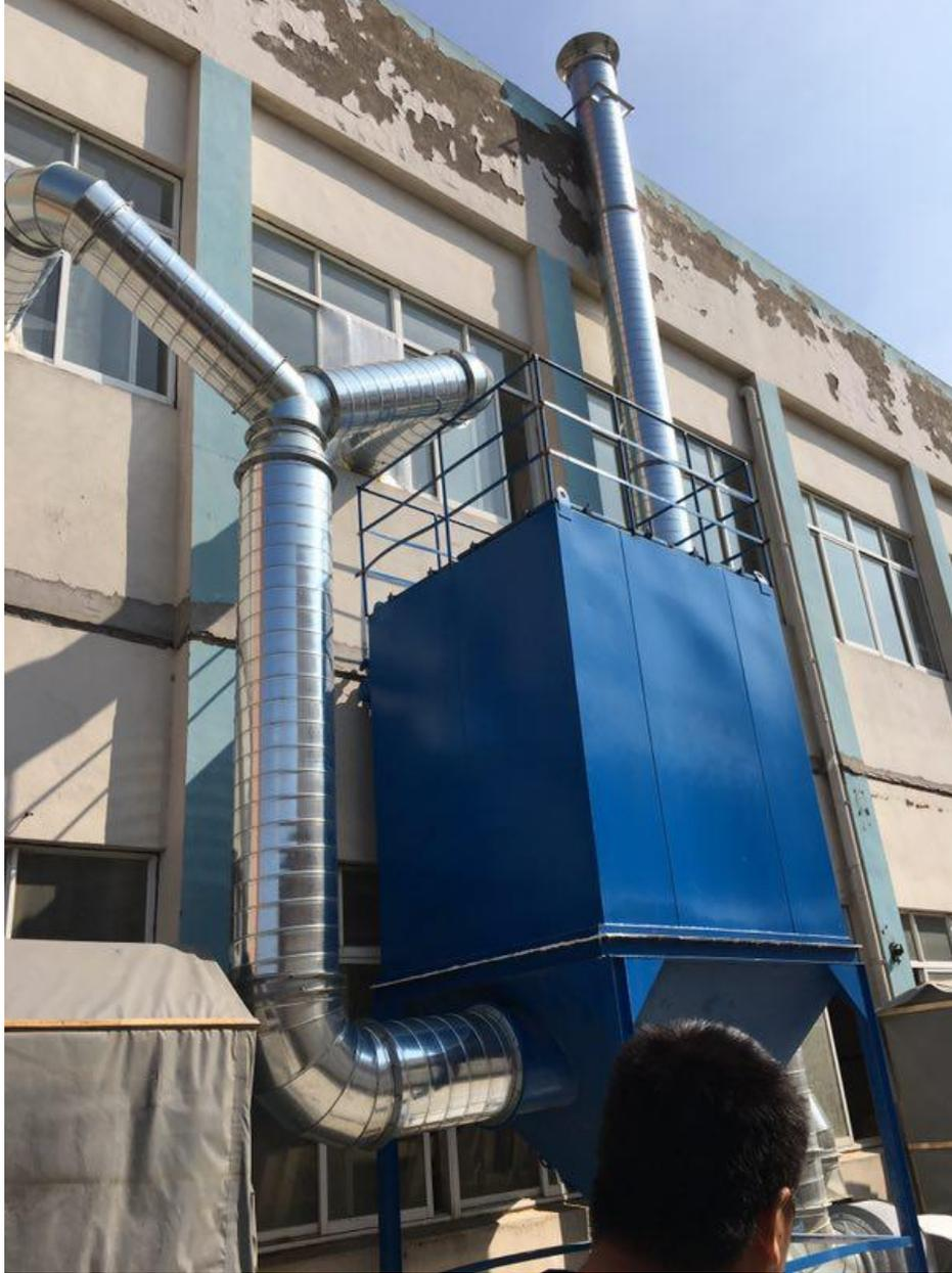
图 4-4 投料打磨粉尘处理设施
