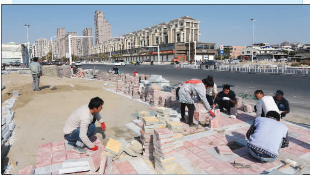
▲昨日, 在宝岛路(学府路-濠江路)段, 工人正在人行道铺设彩色的透水砖。据悉, 宝岛路改造工程正在加快施工进度, 路灯和公交站亭等设施也已安装完毕。(记者 颜华杰)
