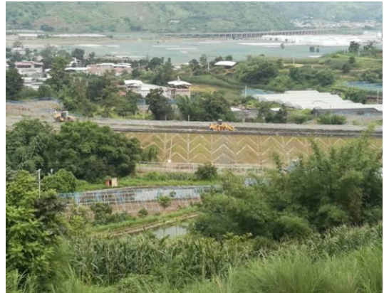
北侧成昆铁路复线（在建）
