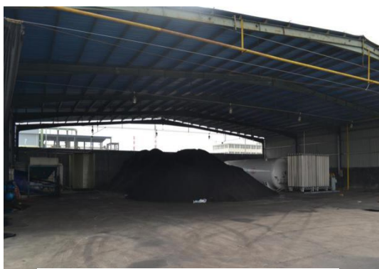
煤场防尘整改前
