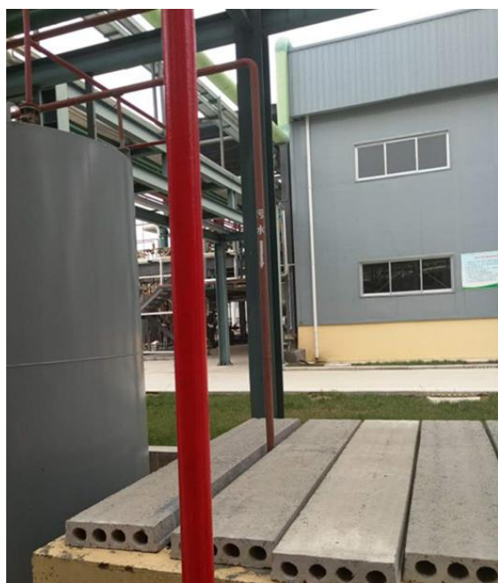
生产装置区应急收集池
