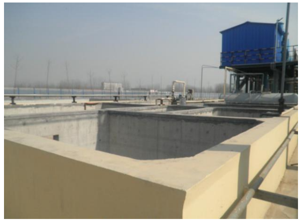
污水站调节池
