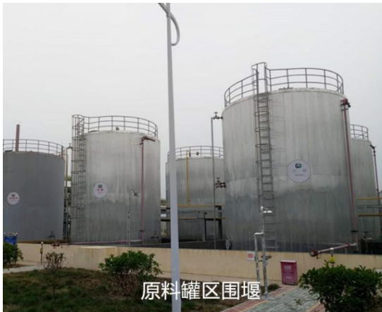
原料罐区围堰
