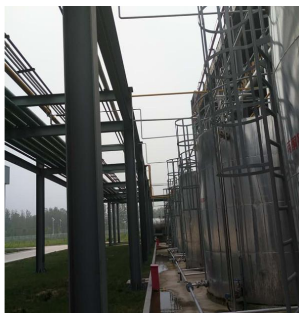
生产装置区围堰
